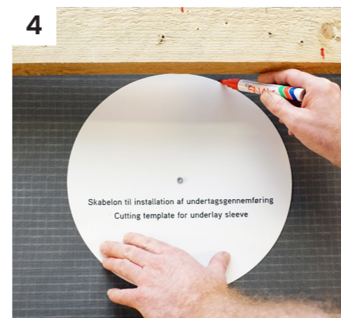
4 Afmærk rundt om skabelonen for udskæring af hul.
