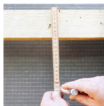
Opmåling fra lægte overkant til midt skabelon.
