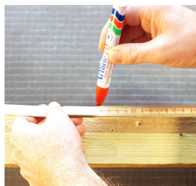
Opmåling fra tagsten til højre til midt skabelon.
